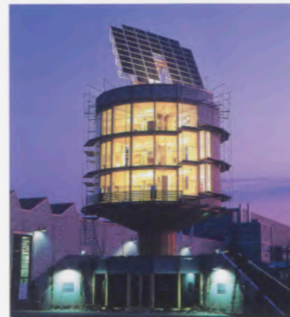
Das 1994 mit dem Umweltpreis des Landes Baden-Württemberg ausgezeichnete Solarkraftwerk des Werkes Offenburg-Eigersweier der Hans Grohe GmbH & Co. KG
