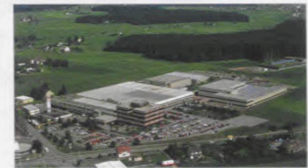
Die Platinen- und Federfabrik KERN-JEBERS GmbH & Co. in Schramberg-Sulgen
