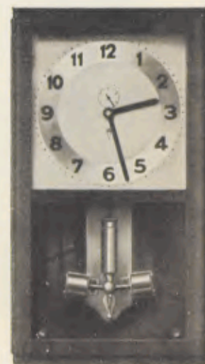
46 cm lang Ato-Schwachstromuhr mit 1/2-Sekundenpendel
