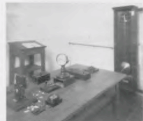
Zeitdienstanlage bei Junghans um 1910 mit Präzisionspendeluhr und Nebenuhr (Sekundenschläger)
